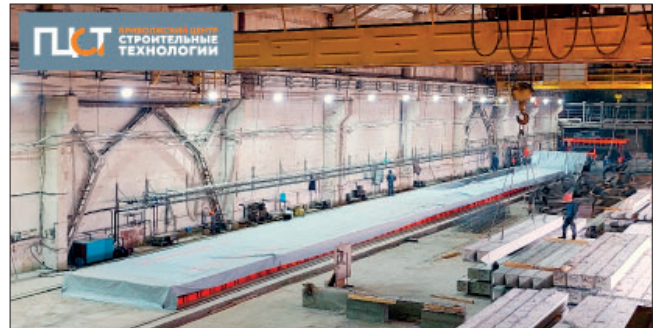
«ПЦ СТ». Вибробетонукладчик ВБУ и тентоукладчик РЗП на производстве ЖБИ
