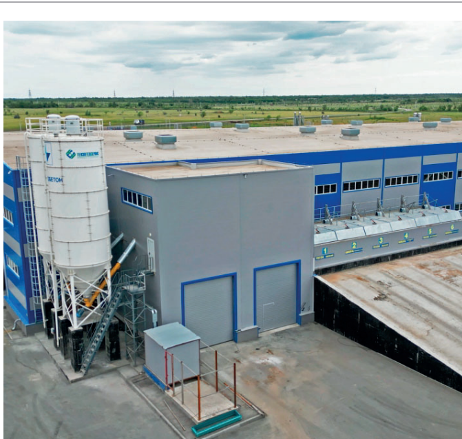
Общий вид производства ЖБИ / БСУ
