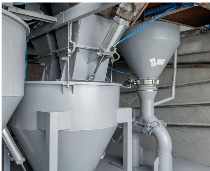
Дозаторная система БСУ
