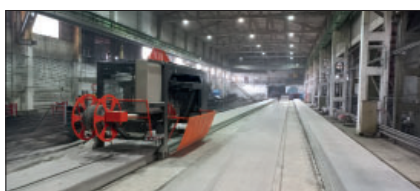
ПЦ СТ производство пустотных плит перекрытия ЛБФ Лента www.pc-st.ru
