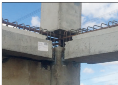
Рис. 6. Узел колонна-ригель Fig. 6. The column-crossbar node
