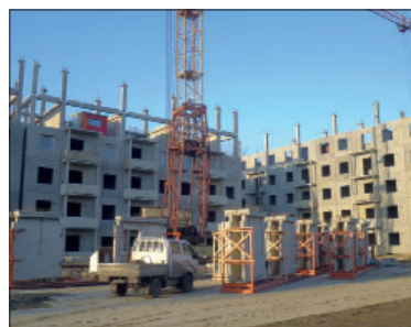
Рис. 7. Строительство жилых домов Fig. 7. Construction of residential buildings
