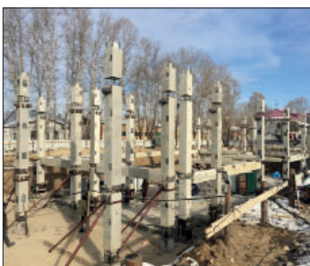
Рис. 5. Монтаж каркаса Fig. 5. Installation of the frame
