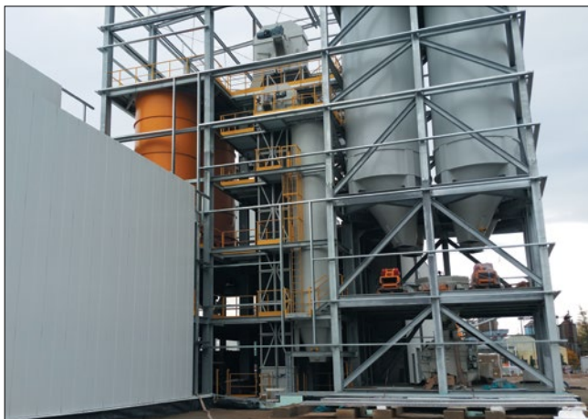
Рис. 3. Монтаж двухвального смесителя и реактора
