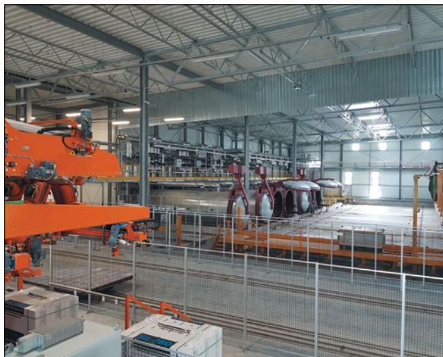
Рис. 6. Тупиковые автоклавы на заводе под Варшавой
